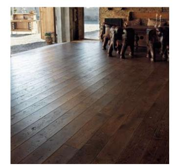
Individuelle und strapazierfähige Holzoberflächen mit FAXE Lauge und Öl: Diese Eichenoberfläche wurde behandelt mit FAXE Speziallauge und FAXE Coloröl im Farbton walnuß. Detaillierte Arbeitsanleitungen zu dieser und anderen Techniken finden Sie unter www.faxe.de
