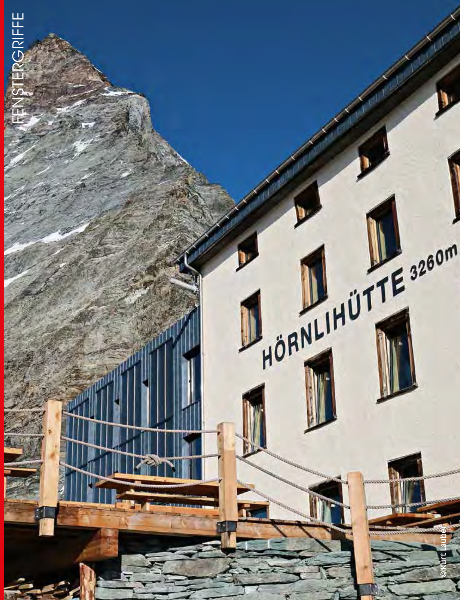
Referenz: Hörnlihütte, Matterhorn, Zermatt, Renovierung: Arnold Perren Zurniwen GmbH
